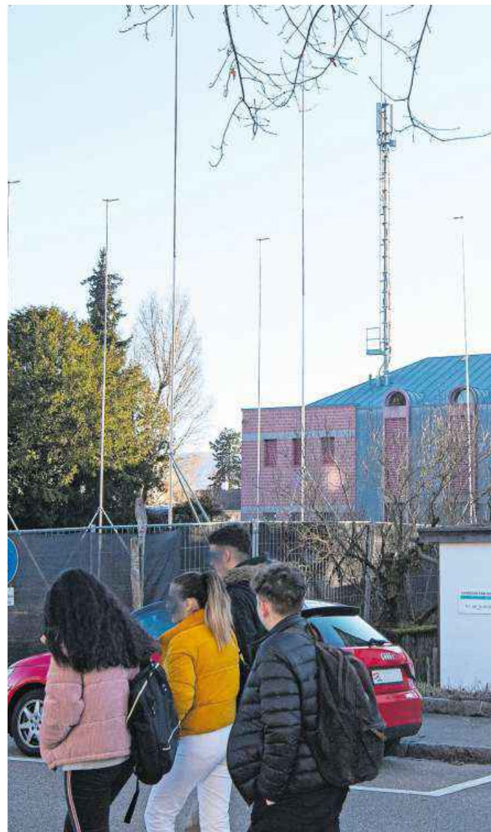
Die Swisscom-Antenne an der Reinacher Graham-Bell-Strasse unweit von Schulen soll erhöht werden. Bild: Nicole Nars-Zimmer (6.2.2020)
